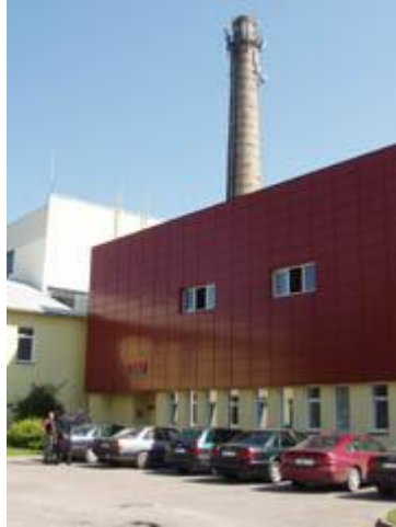
Fig. 5. AB Panevezio energija, Kedainiai subsidiary (Photo by Panevezio Energija)
